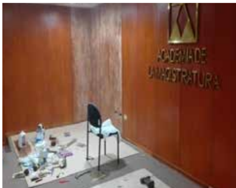
Refacción de auditorio central
