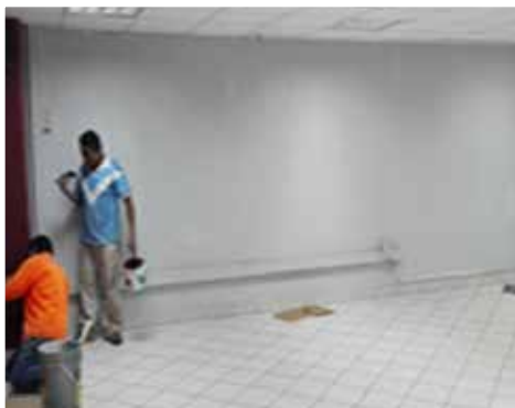
Refacción de auditorio central
